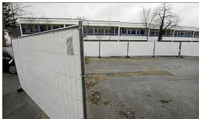
Neben der Lembergschule entsteht der neue Parkplatz.
